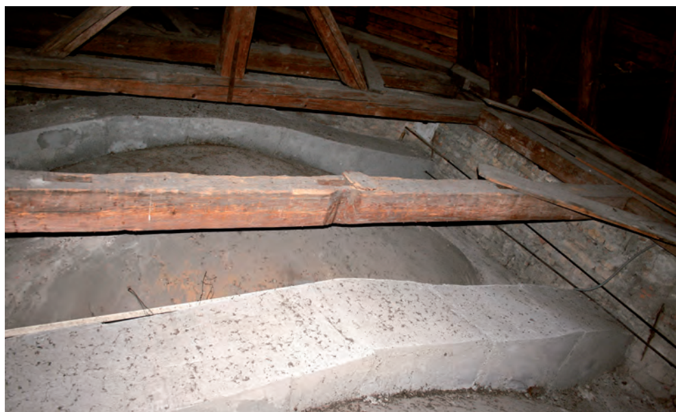
Obr. 11 Kostel ve Staříči, statické zajištění klenby presbytáře, foto, 2010 Fig. 11 Staříč church, presbytery vault – statical securing, photo, 2010
