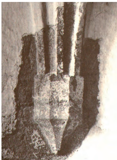
Obr. 18 Klenební konzola, tvrz Staré Kestřany. Převzato z Kuthan 1994 Fig. 18 Vault console, Staré Kestřany stronghold, after Kuthan 1994
